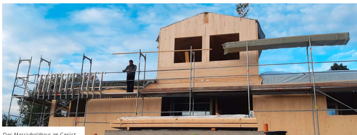
Das Massivholzhaus im Gerüst
